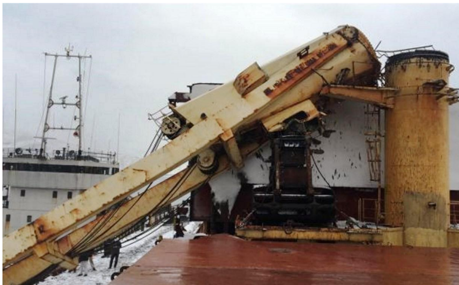
Рис. 3. Технологическое разрушение судового крана при рейдовой погрузке угля в порту Невельск (слева – надстройка погрузочного судна) [11]
